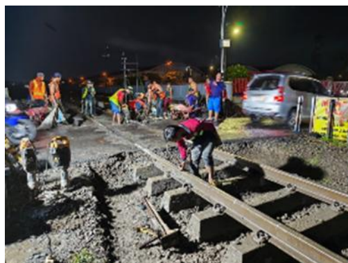
Gambar 2. 38 Monitoring Perbaikan Geometri Jalan Rel
