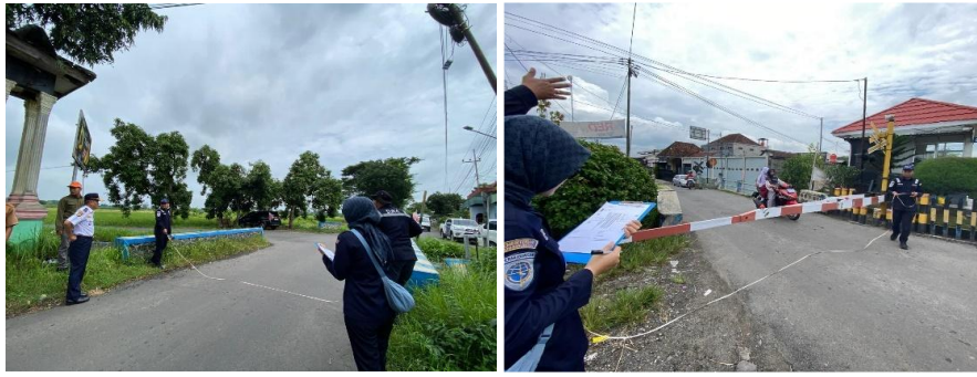
Gambar 2. 69 Tinjauan Lapangan Perbaikan JPL Rusak
