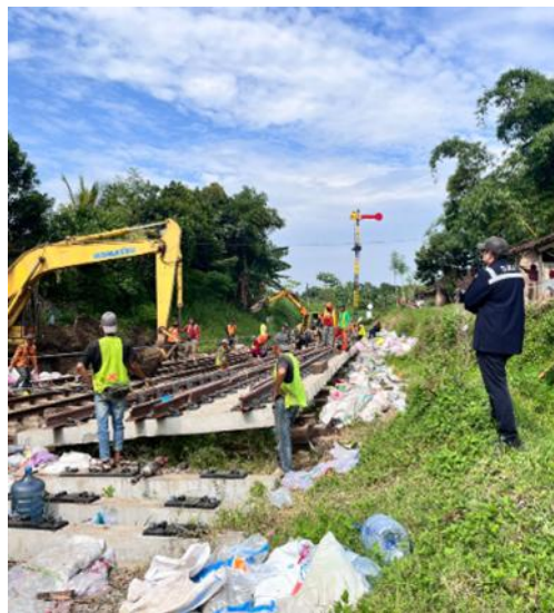
Gambar 2. 48 Switch Over Penggantian wesel 02
